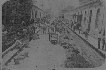
La obra admirable de la pavimentación de concreto en San José AVENIDA 1ª ENTRE CALLES 6 Y 8
